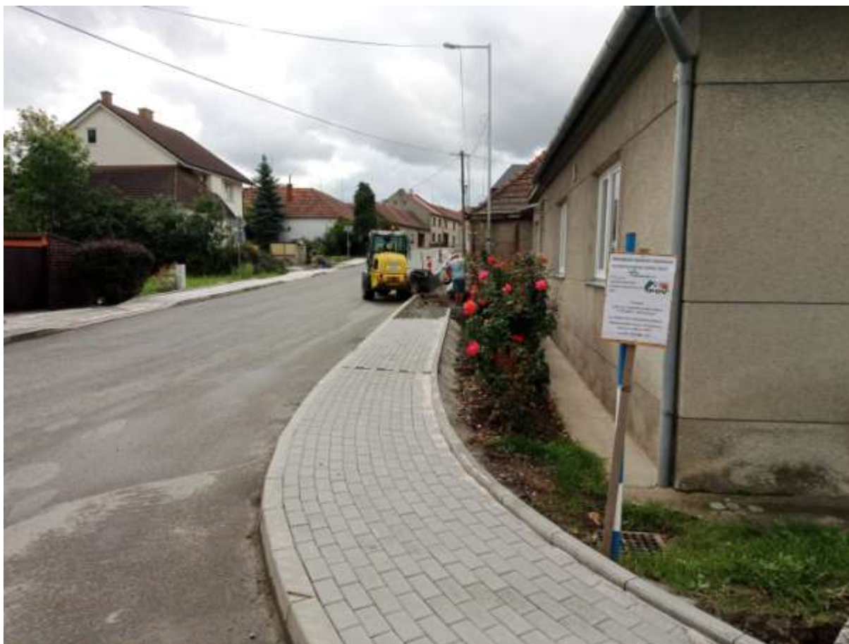
Křižovatka silnice č. III/4481 s místní komunikací.
