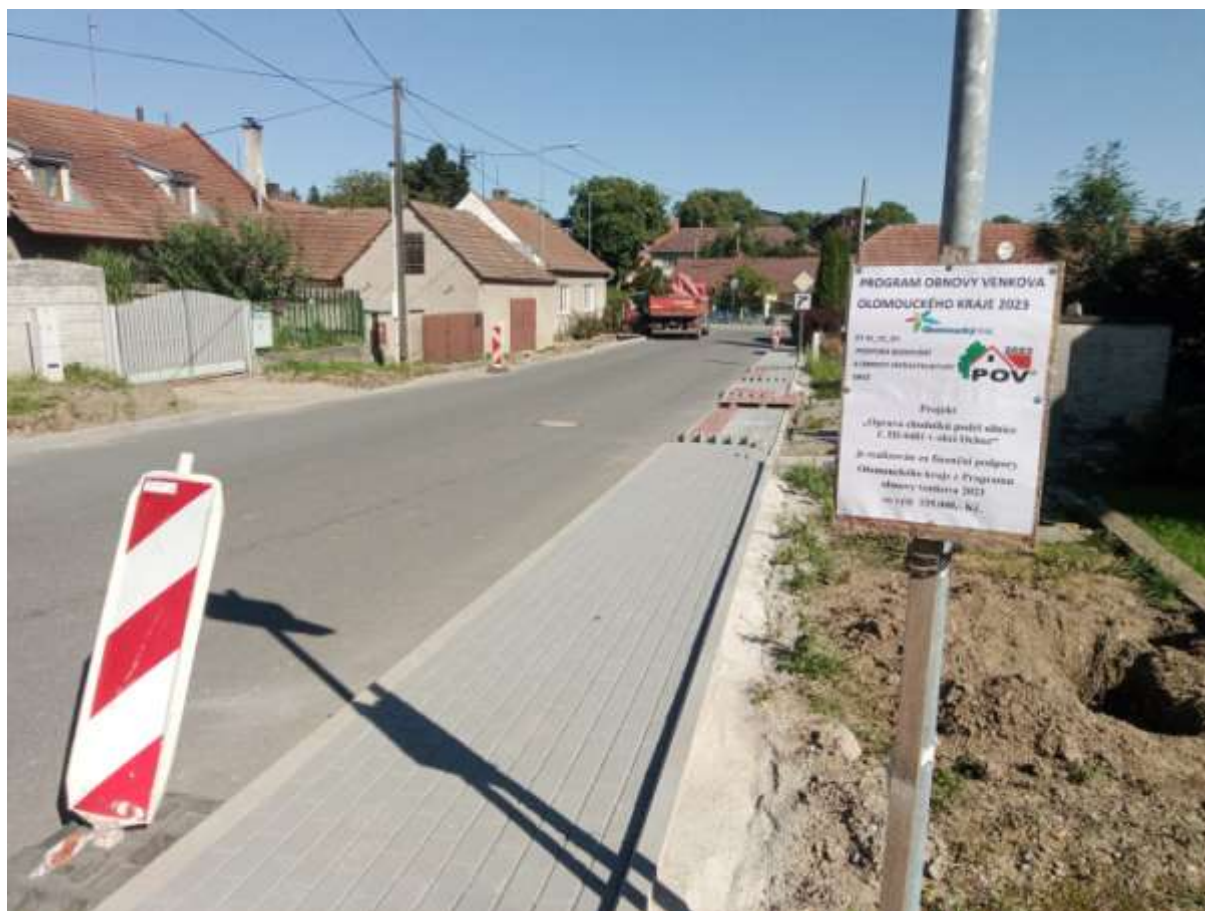
Chodníky podél silnice č III/4481 - směr do Bohuslavic.
