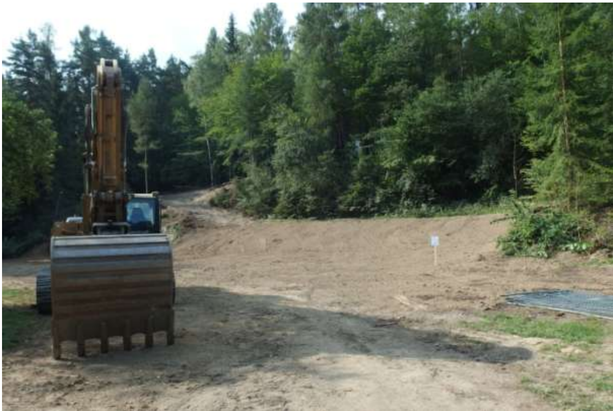
Prostor po demolici provozní budovy po provedení terénní úpravy.
