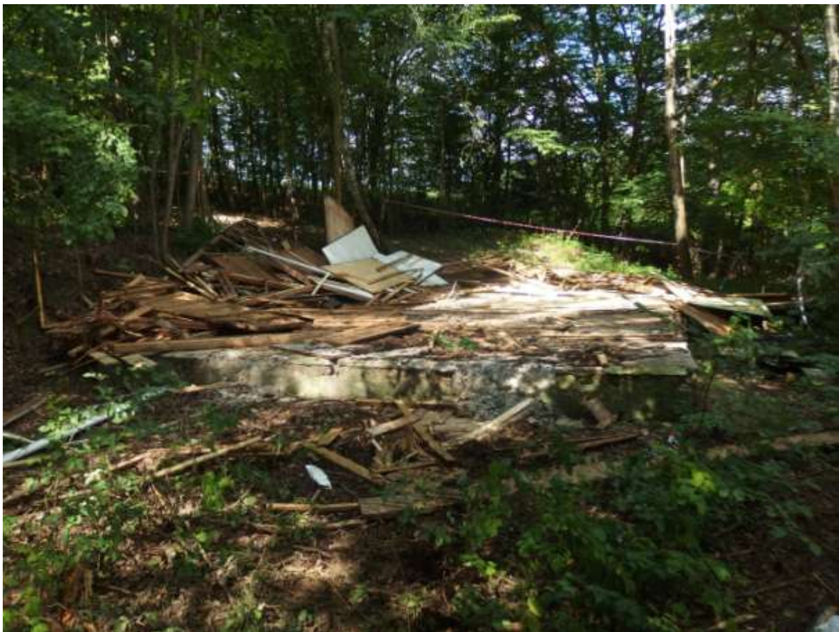
Demolice obyčejné chaty.
