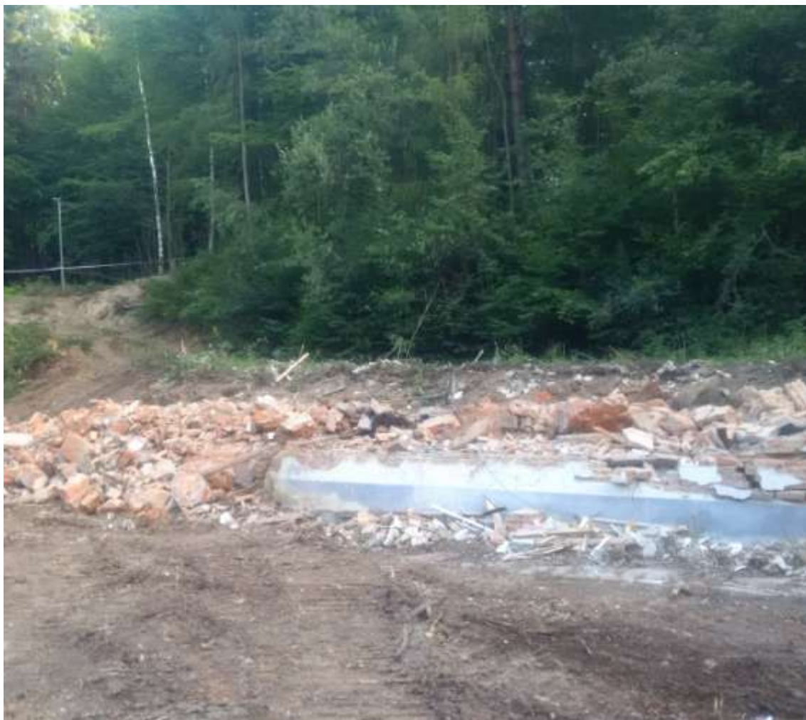
Demoliční odpad na základové desce provozní budovy před odvozem na skládku.
