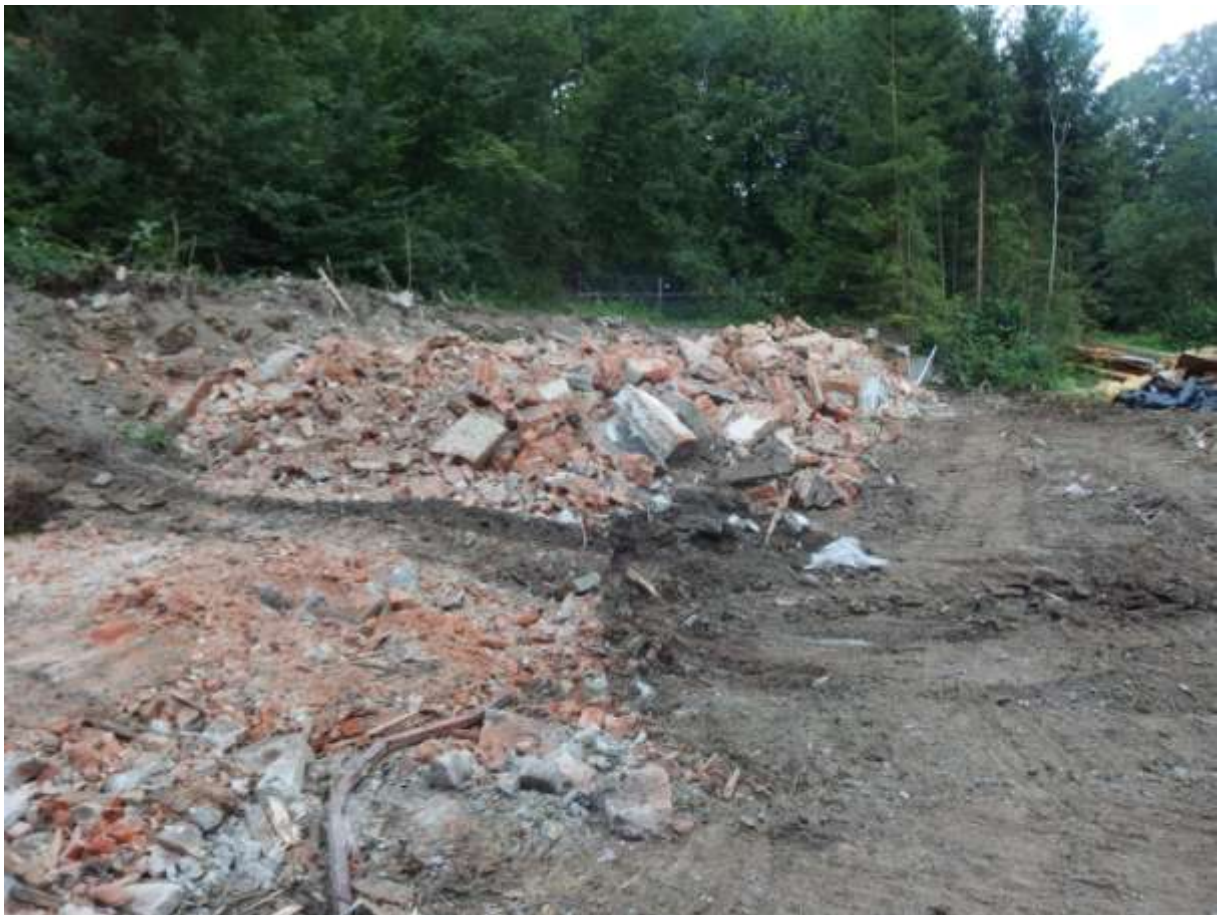
Demoliční odpad připravený k odvozu.
