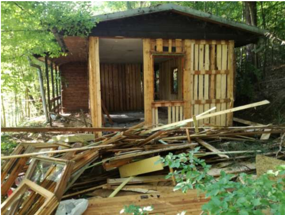
Demolice obyčejné chaty.
