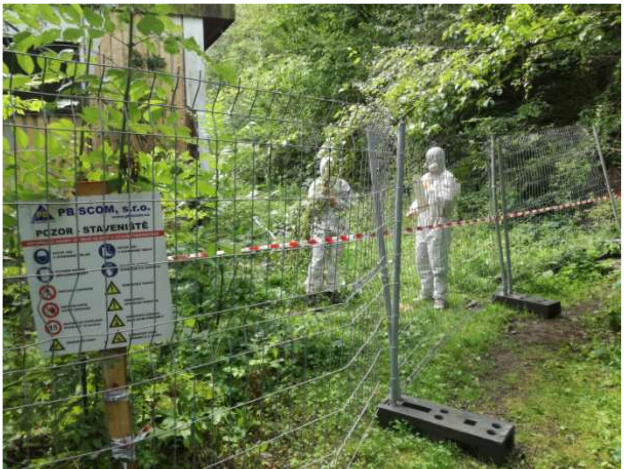
Odstraňování desek s obsahem azbestu.
