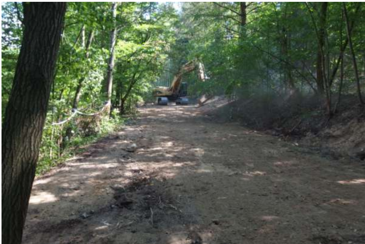
Provádění terénních úprav po odstranění obytných chat.
