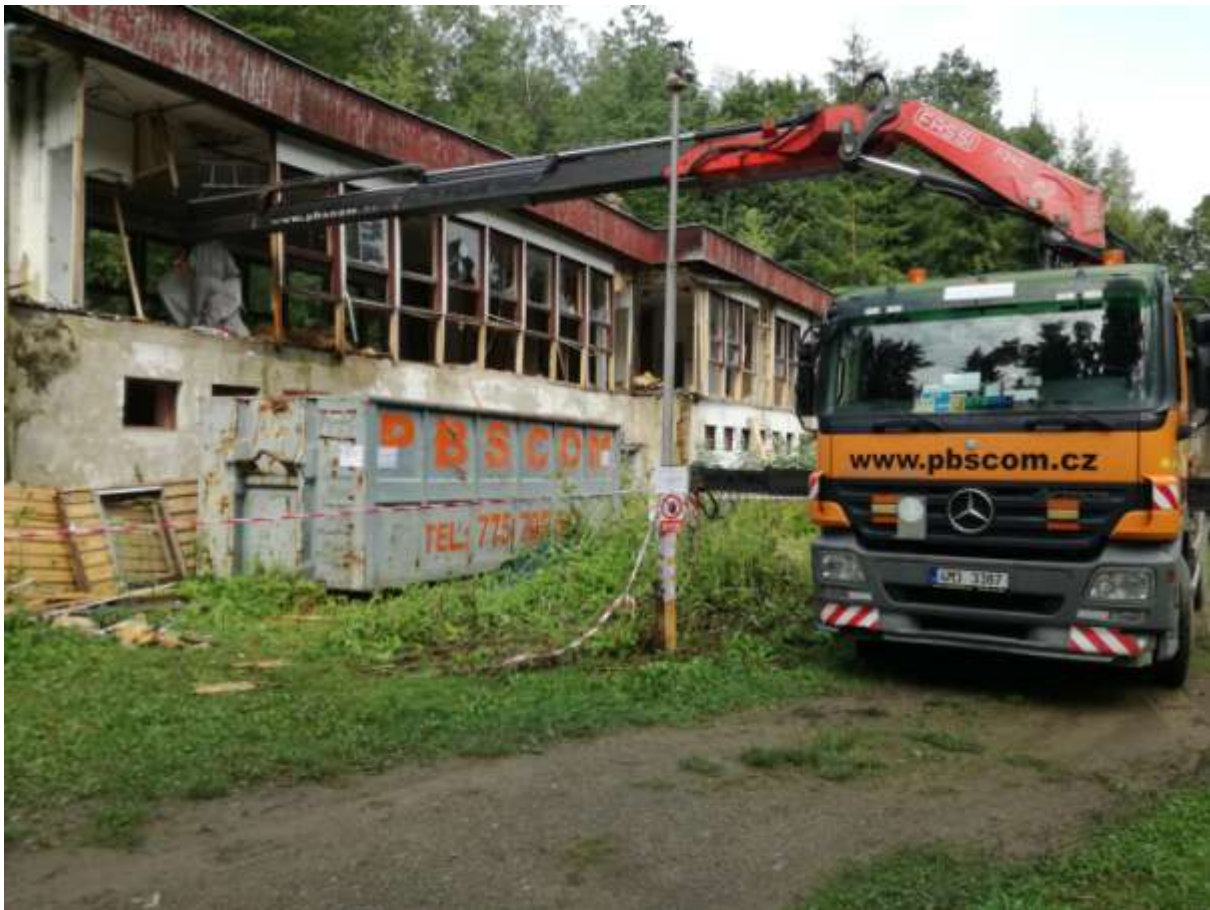
Nakládání vaků s odpadem s obsahem azbestu.
