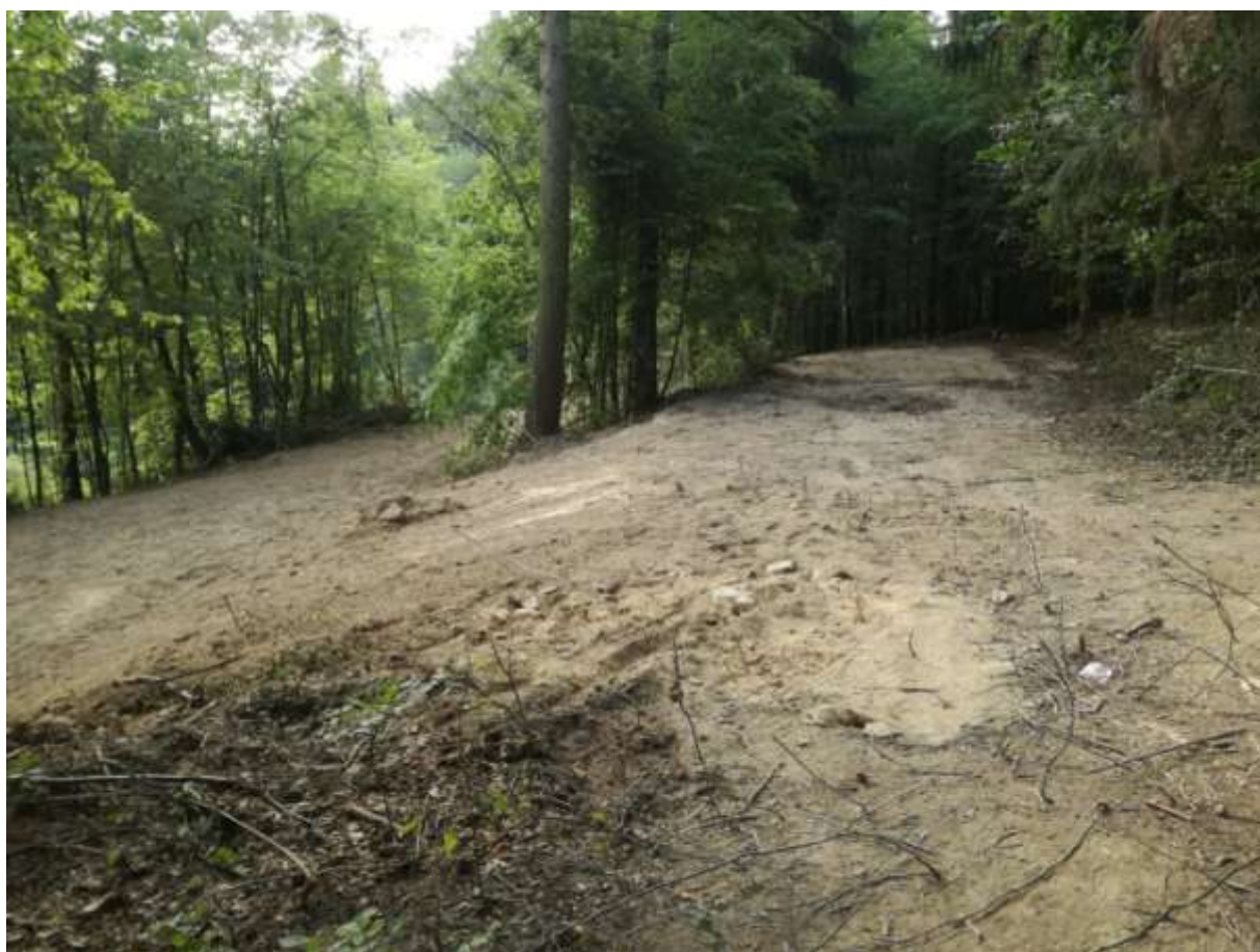
Terénní úprava na místě obytných chat po demolici.
