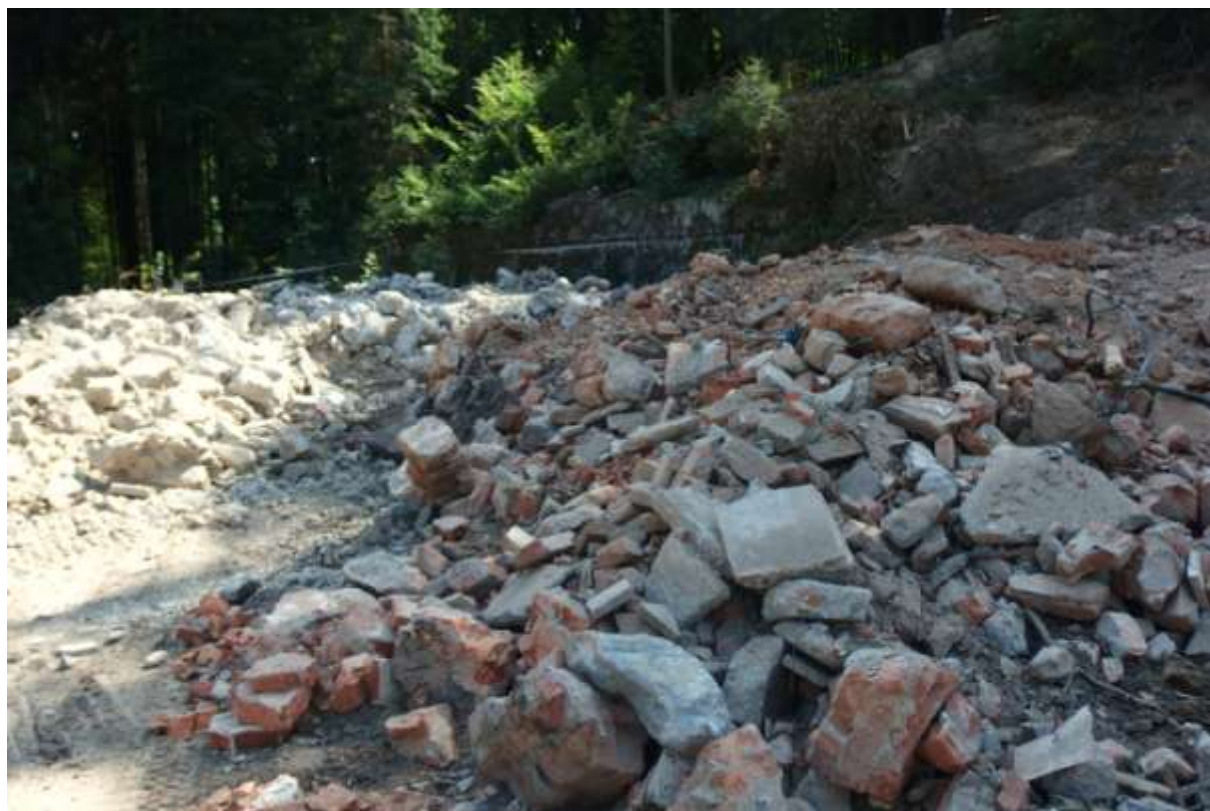
Demoliční odpad připravený k odvozu.
