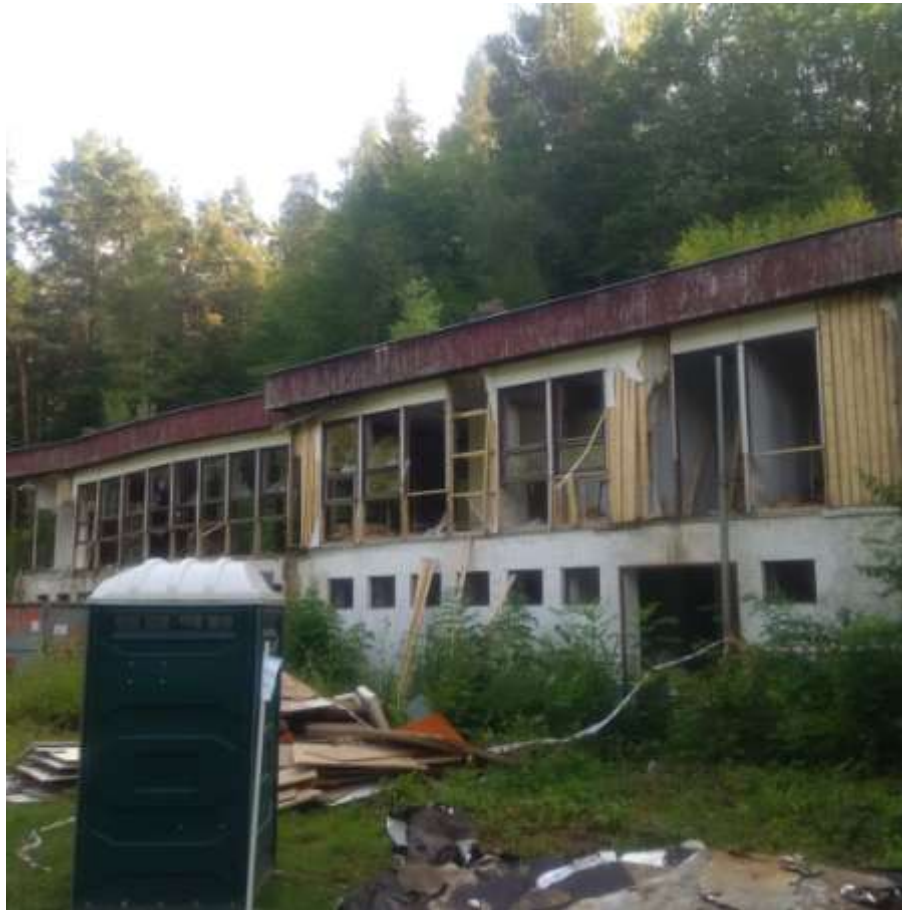
Zahájení demolice provozní budovy.
