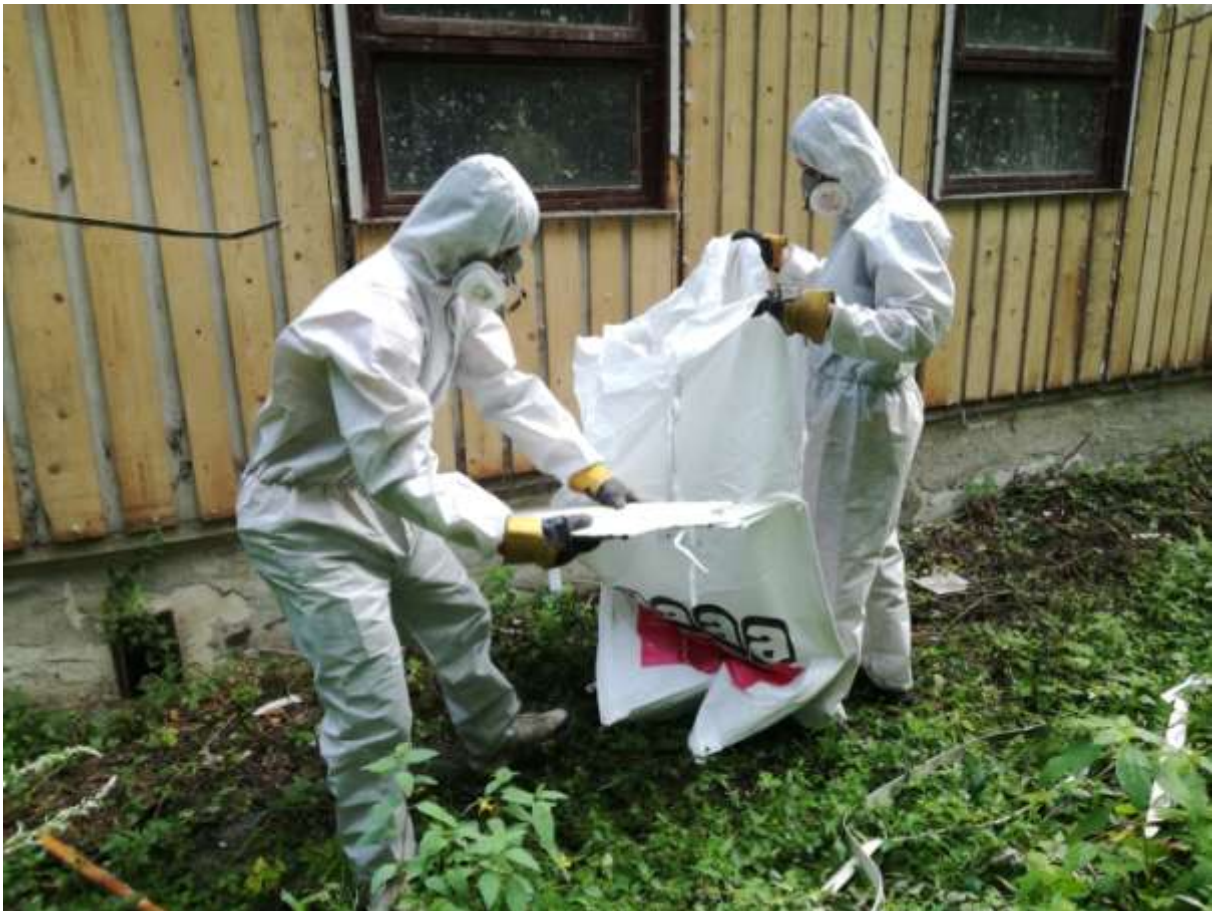
Odstraňování desek s obsahem azbestu.
