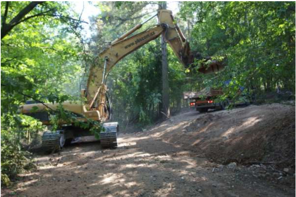
Provádění terénních úprav po odstranění obytných chat.
