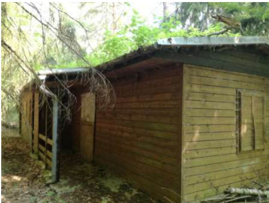
Ubytovací chata před demolicí.
