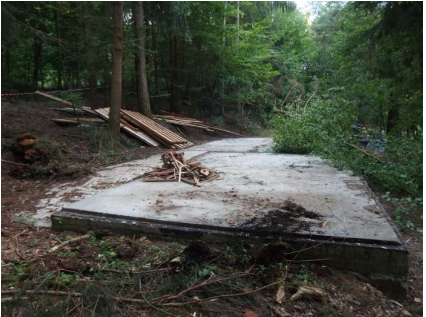
Základová deska obytné chaty před demolicí.
