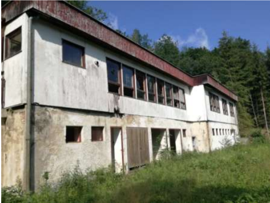
Provozní budova před demolicí.
