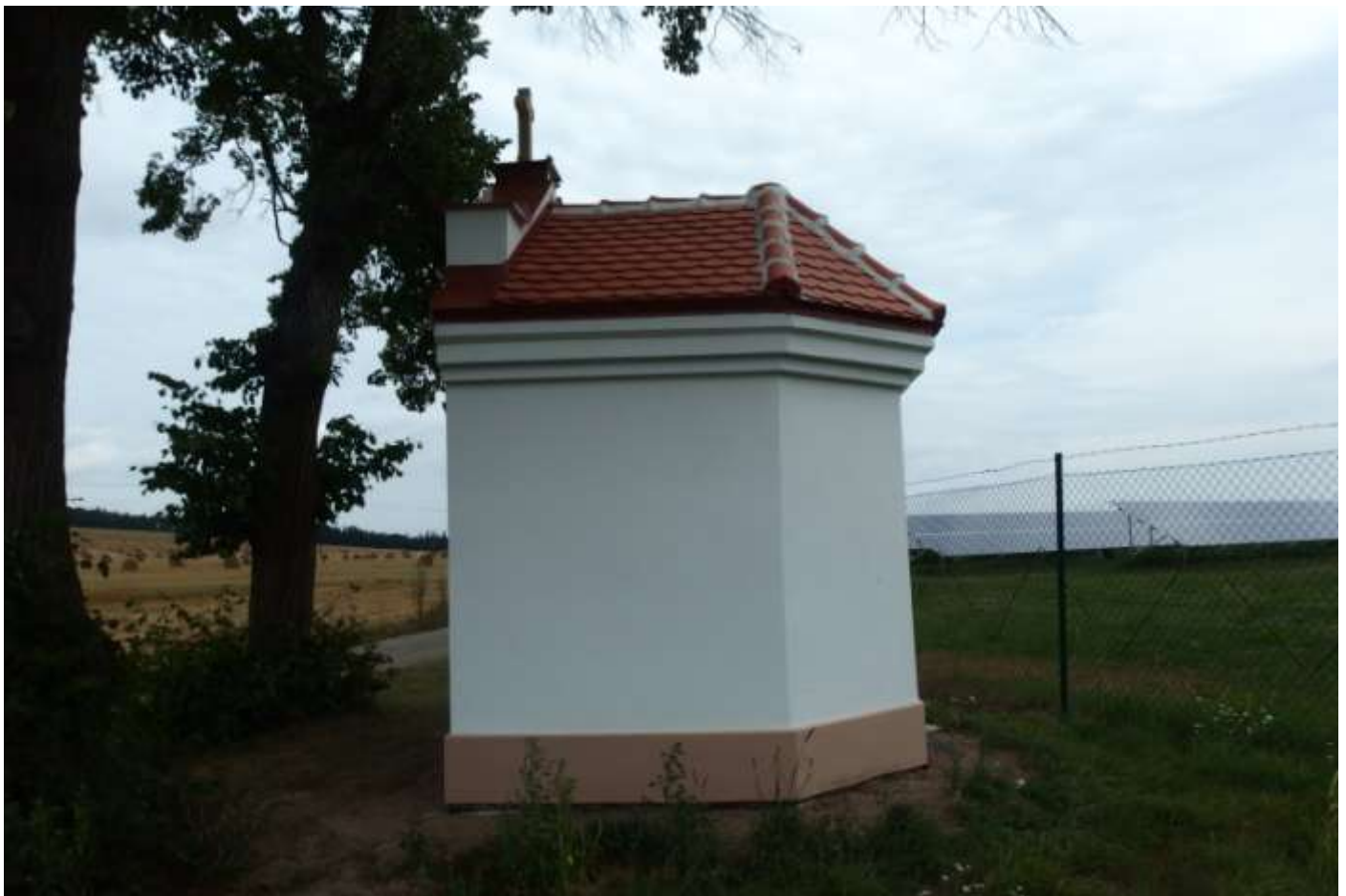
Pohled na kapličku z jihozápadu.
