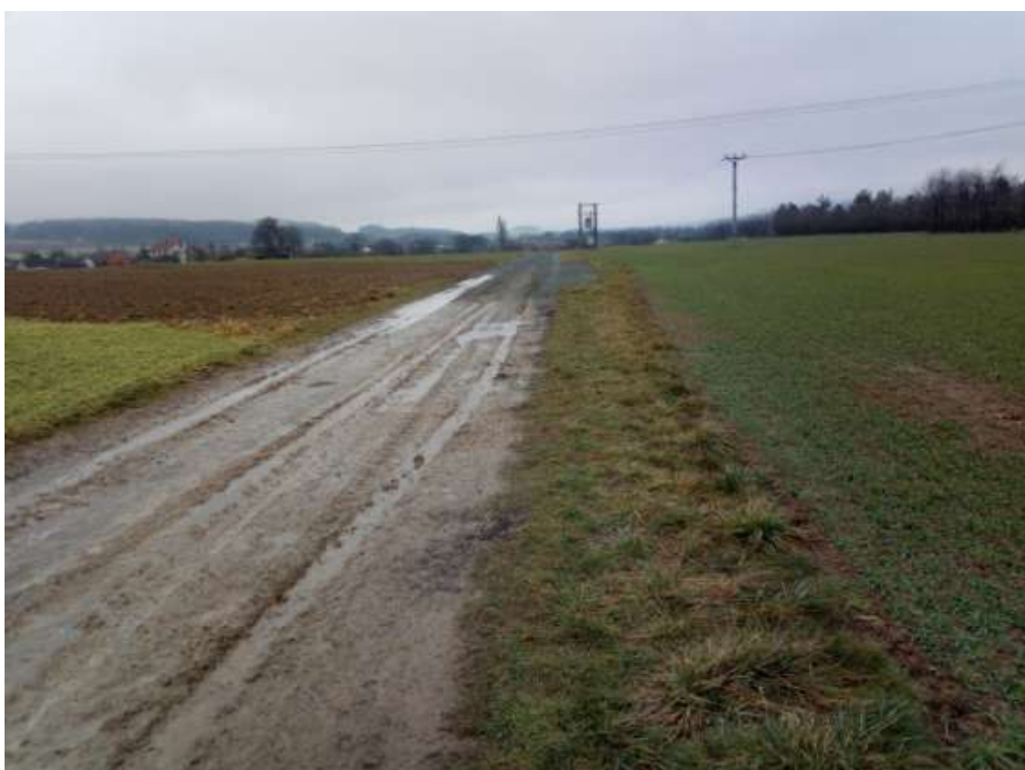
Stávající komunikace ve směru od Budětska do Ochoze – před místem napojení na část realizovanou v II. etapě.
