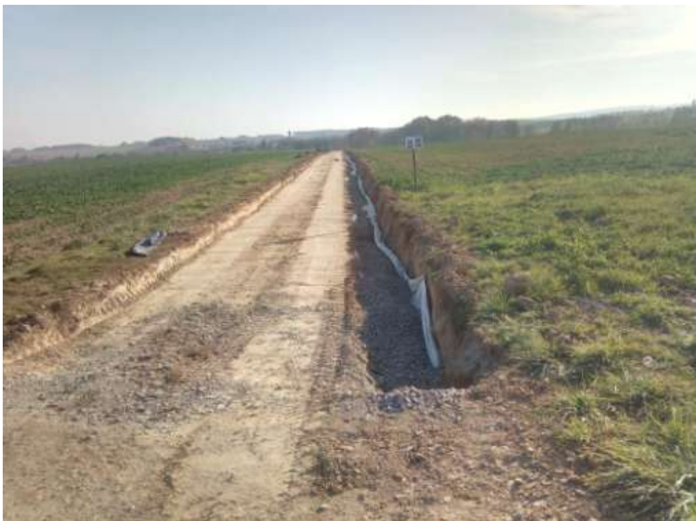
↑ Pohled od Ochoze z části komunikace (výhybny) realizované jako 2. etapa výstavby v roce 2017 štěrkový obsyp odvodnění.
