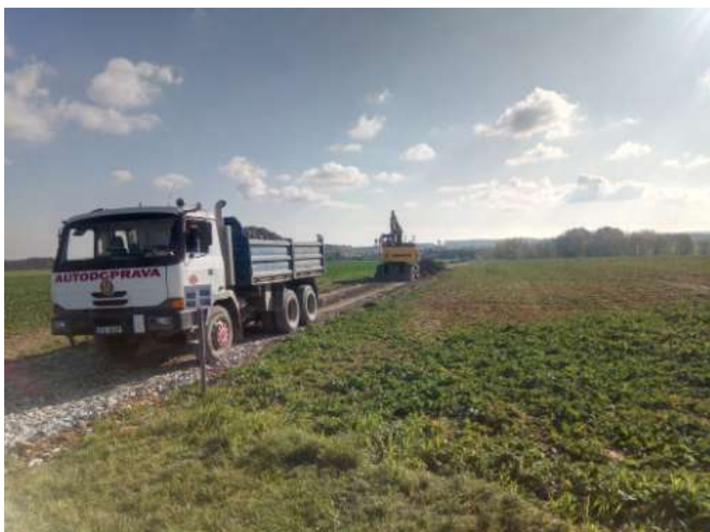
↑ Pohled od Ochoze na střed 3. etapy výstavby komunikace – navážení a rovnání štěrku.
