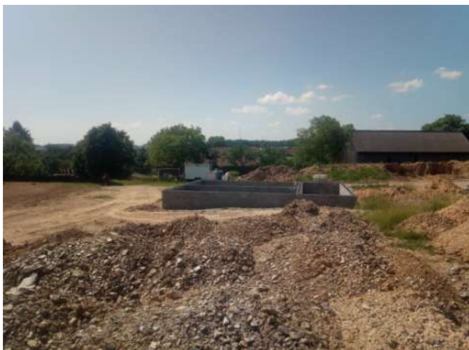
Pohled ze severní části pozemku parc. č. 2331.
