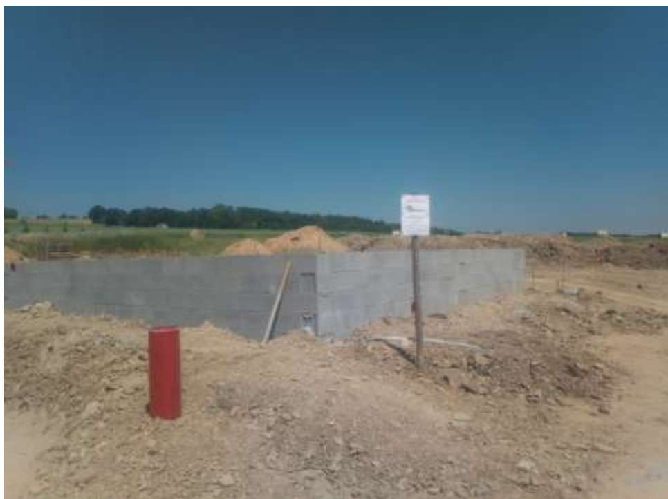
Pohled na výstavbu základové desky z jihu.
